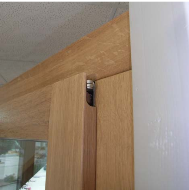
Bild 5: Ausfräsungen für verdeckt liegendes Scherenlager
