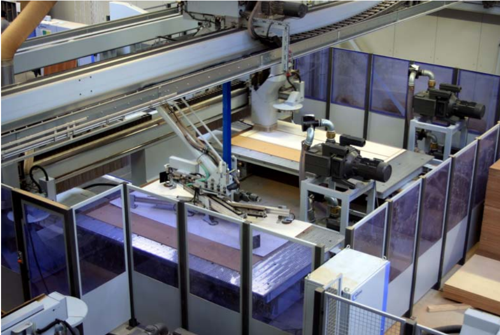
Bild 3: Zelle 1 HOMAG Bearbeitungszentrum mit direkter Beschickung aus dem Plattenlager
