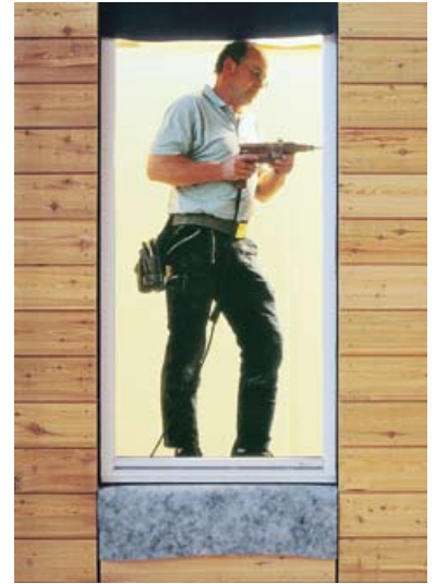
► Auch der Fenstereinbau erfolgte im Holzbaubetrieb
