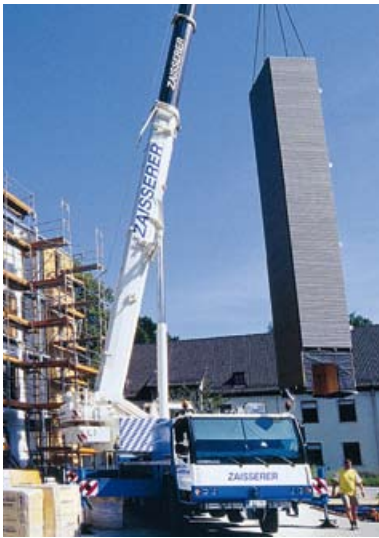
◀ Selbst der Aufzugsschacht ist aus Holz
