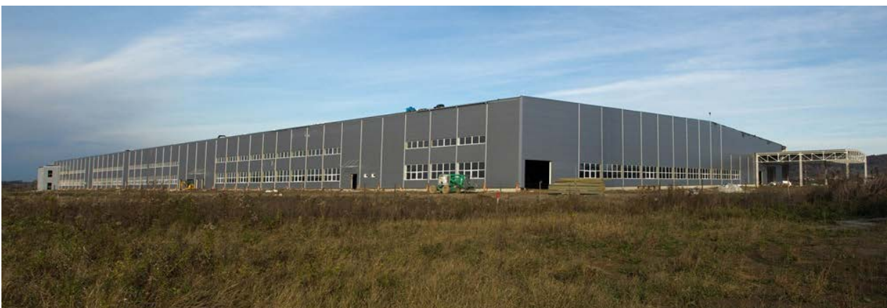
Bild 1: Das neue Möbelwerk in Jaslo/Polen – Inklusive Lagerfläche und Sozialräume beträgt die Gesamtfläche des neuen Werkes 24.500 m 2 .
