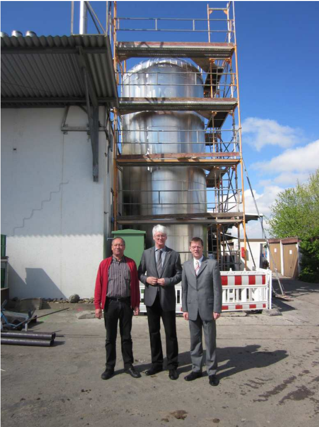
Bild 1: Karl Schäfer (Leiter der Werksinstandhaltung), Herbert Högemann (Geschäftsführer HOMAG) und Klaas Klaassen (Bürgermeister Schopfloch) besichtigen die Baumaßnahmen.
