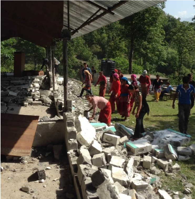
Bild 2: Die Außenwände der Schule stürzten komplett ein...
