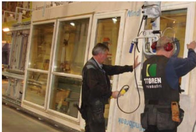
Ergonomisches einbauen der Fensterelemente / Ergonomic installation of window elements
