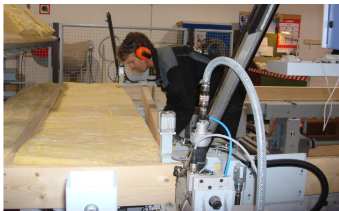
Montaż izolacji na stacji zbijania szkieletu ściany / Installation of insulation at the framing station
