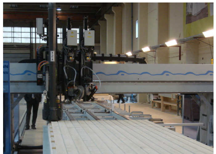
Automatyczne docięcie i mocowanie deskowania za pomocą mostu wielofunkcyjnego Automatic cutting and planking of the formwork with the multi-function bridge
