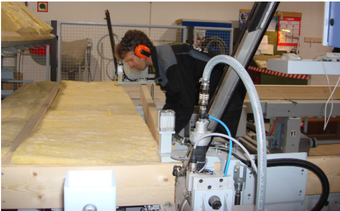
Introducerea izolatiei pe statia de asamblat cadrele din lemn Installation of insulation at the framing station
