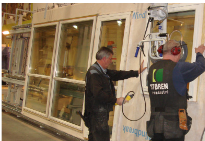
Эргономичный процесс вставки окон в стеновые панели Ergonomic installation of window elements
